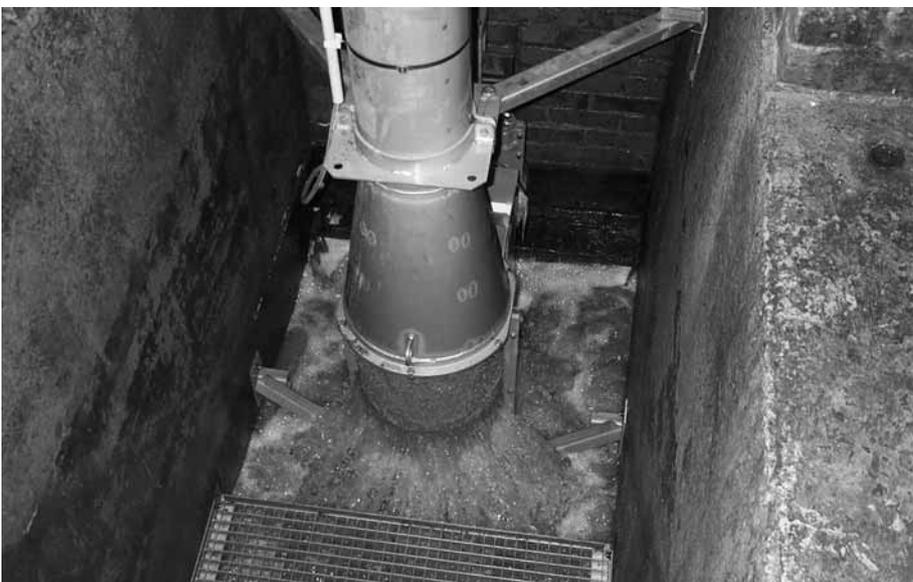
**Bild 2:** Die Siebanlage hält Störstoffe über 3 mm Durchmesser aus dem im Folgenden zur Energiegewinnung genutzten Abwasserstrom zurück.
