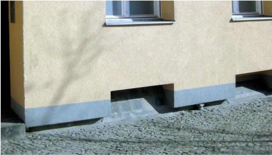
**Wärmedämmung an der Außenwand – Tiefe sichtbar an den Kellerschächten**
