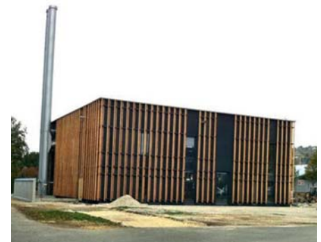
Abbildung 3: Die Errichtung des Biomasseheizwerkes mit Wärmeverbundnetz im Bereich Eichstätt Ost-Schottenau (2)
