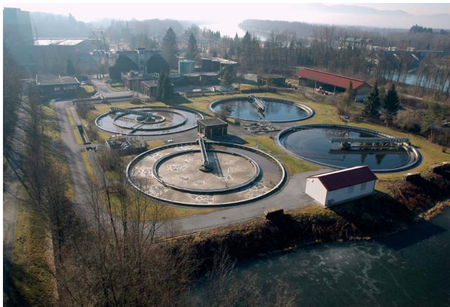
Die Kläranlage Bockau
