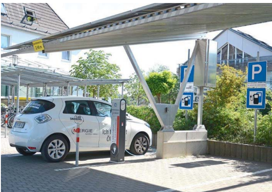
Perfekt gelöst – die Stromtankstelle in Buckenhof: Der Strom für das Elektrofahrzeug wird im Solar-Carport erzeugt.
