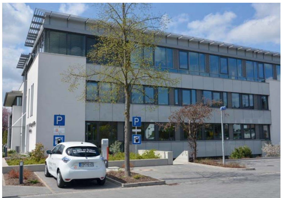
Die Errichtung der Ladestationen stellt gemäß Art. 18 Bayerisches Straßen- und Wegegesetz eine Sondernutzung dar und bedarf der Genehmigung durch die Gemeinde. © Georg Güthlein
