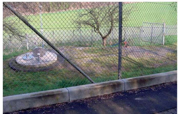
**Abb. 4:** Anlage eines Hochbordes am Zaun zur Wasserschutzzone I zur Entwässerung und Vermeidung von Auswaschungen von Hundekot.
