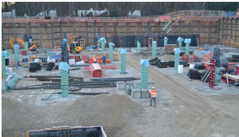
Hoher Flächen- und Baubedarf in Bayern: Neue baurechtliche und steuerpolitische Ansätze sind dringend erforderlich.
