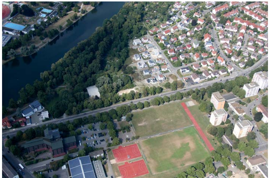
Von Anfang an energetisch konzipiert – KfW-Effizienzhaus 40-Standard, Fernwärmeanschluss, Photovoltaikanlagen, Südausrichtung der Gebäude und vieles mehr. Der Bauplatz für das nun gebaute vorbildliche Wohngebiet „An den Pflögärten“ in Neu-Ulm.
