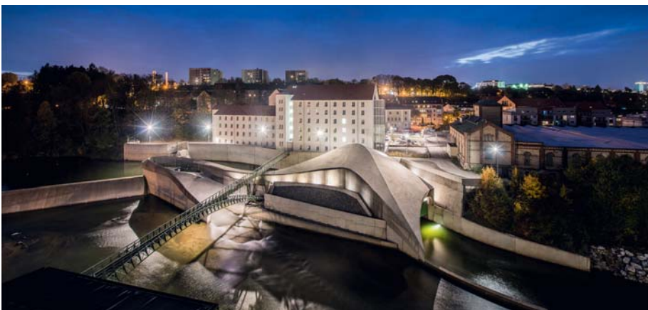
Das Wasserkraftwerk an der Keselstraße – ein ausgezeichnetes Projekt der Allgäuer Überlandwerk GmbH (AÜW), das moderne Architektur mit der Nutzung erneuerbarer Energien verbindet.
