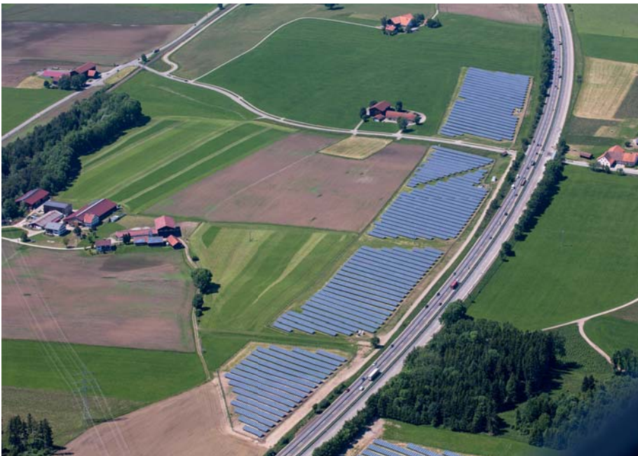
Freiflächen-Photovoltaik-Anlage Unterwengen entlang der Autobahn A 7. In der Gemeinde Haldenwang wird pro Jahr mehr Strom aus erneuerbaren Energien erzeugt als verbraucht wird.
