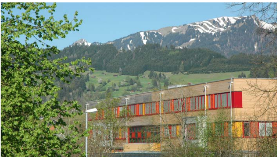
Das Gymnasium Sonthofen erstrahlt in neuem Glanz und wird dem umgebenden Bergpanorama gerecht.
